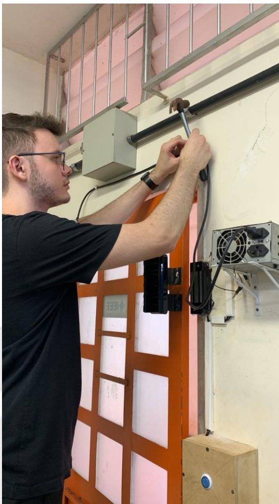
Figura 43 – Processo de Instalação
